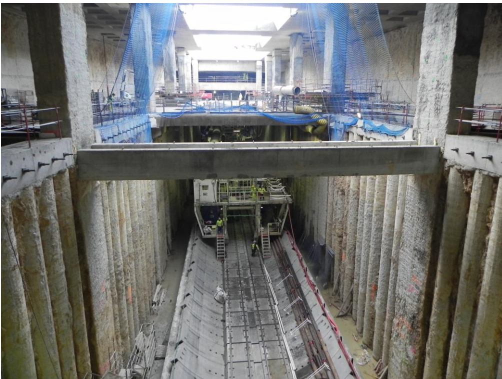
Fotografía 3: Vista de la estación desde el forjado de parking superior en la que se ve el back-up de la tuneladora pasando por el recinto central de pantallas de pilotes y en el que se pueden observar los múltiples agujeros destinados para los accesos de la estación.
