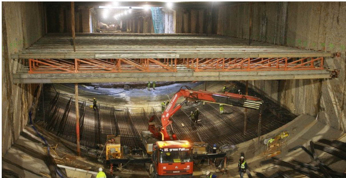
Fotografía 5: Vista del telescopio sur de la estación en la fase en la que se está ferrallando la contrabóveda.
