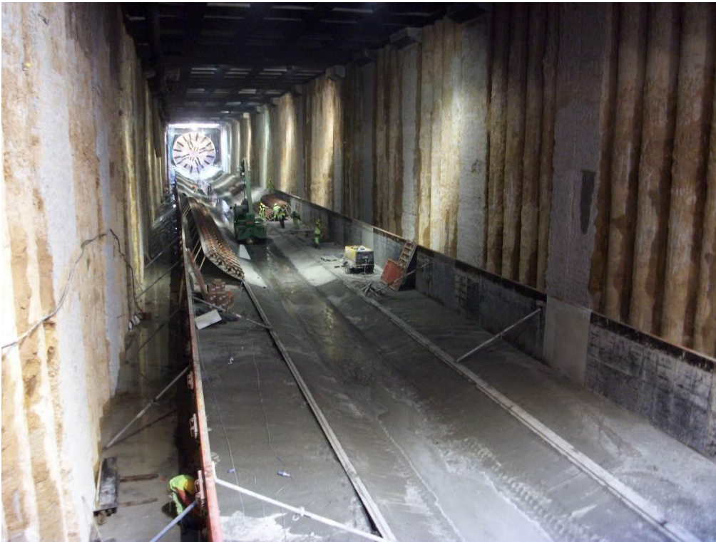
Fotografía 2: Vista del túnel central con la tuneladora al fondo arrastrándose por la cuna en construcción justo por delante de ésta.
